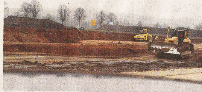
In Nörten-Hardenberg entsteht der Neubau für 250 Mitarbeiter. FOTO: HINZMANN
